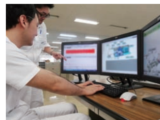
LAN, Mobile telephone line etc. LAN、携帯電話回線など
